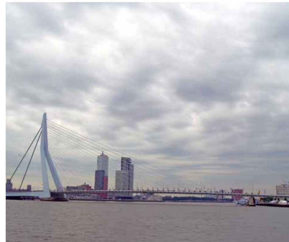
Erasmusbrug in Rotterdam: een tuibrug zoals die bijna in Antwerpen gebouwd werd. Ferdi de Gier
